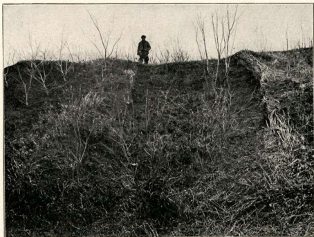
Фашинный спускъ, которым укрѣплена вершина Николаевскаго оврага, осень 1901 г. Снято весной 1909 г.
