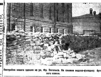
Постройка нового здания на ул. Ф. Энгельса. На снимке подвод(клад) будущего здания.
