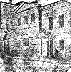
НА СНИМКЕ — капитальное отремонтированное здание верстак и пружинный станок
