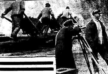
Мониторинг завод на ст. Едвардо, Островского округа, крупнейший в СССР. Его постройка обходится в 3 миллиона руб. На снимке — отдельные моменты строительства.
