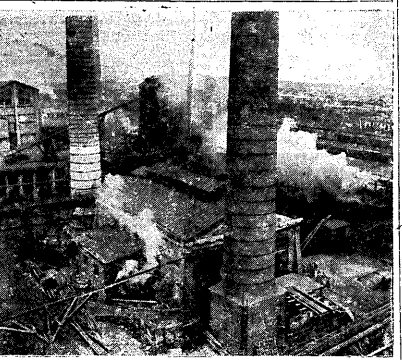
Крупнейший котельный завод, законченный в 1954 г. Завод работает в течение 200 тысяч часов в год. На снимке — общий вид котельного завода
