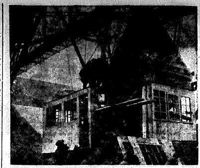
Рыковский гос. металлургический завод механизуются. На снимке—устройство электро-рудачехи для подачи руды в электроду.
