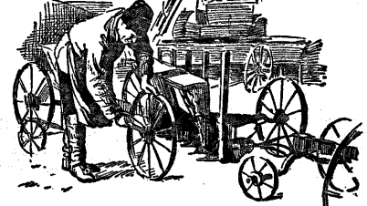
В арти «Новая думка» (Россия) значительный ремонт буферов и востановление поврежденной системы.
