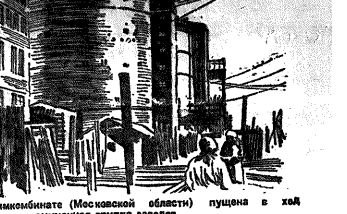
На Берлинском химкомбинате (Московской области) пущена в ход автоматизированная группа заводов.
