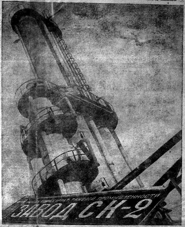
На левом берегу реки Воронеж, где 15 месяцев назад был пущен, вырас второй в мире завод синтетического каучука, высятся мощные 36-метровые струбберы.
