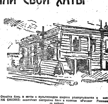
Строится баня в центре культпоходами широко развита в колхозе «Рассвет» Россохинского района.
