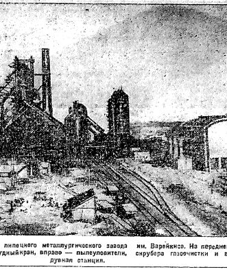
Общий вид доменного цеха лицевого металлургического завода им. Варяжских. На первом плане — дом № 2, вправо идет грунтовой туннель, вправо — пылеуловитель, срубера газосети и воздушная станция.
