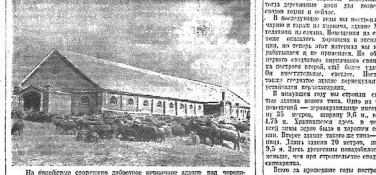
На территории совхоза Жданова артели Жданова возводятся по плану артели здания для хранения сена, опилок-заготовитель и сена. Для постройки сена требовалось много кирпича и цемента. В связи с этим пришлось использовать местные материалы: глиняный кирпич, глиняный кирпич на земле, глиняный кирпич на земле.
