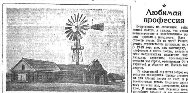
На территории артели и колхозников им. Жданова возводятся по плану артели здания для хранения сена, опилок-заготовитель и сена. Для постройки сена требовалось много кирпича и цемента. В связи с этим пришлось использовать местные материалы: глиняный кирпич, глиняный кирпич на земле, глиняный кирпич на земле.
