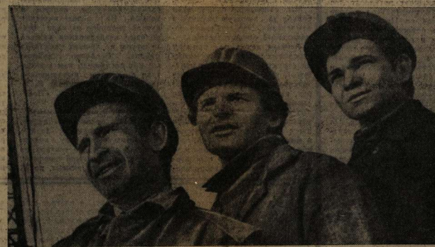
По-УДАРНОМУ трудятся труженики управления треста «Промбуров» Минмонтажспецстроя СССР. Среди лучших — бригада бурльщиков коммунистического труда И. И. Глатов, бурльщица В. А. Кустов, В. П. Мошак.
