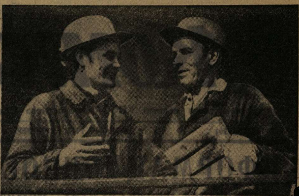
ЕЩЕ ОДИН жилой дом скоро вступит в строй в Юго-Западном районе. Сейчас здесь работают сантехники Воронежского управления треста «Югостокантехмонтаж».
