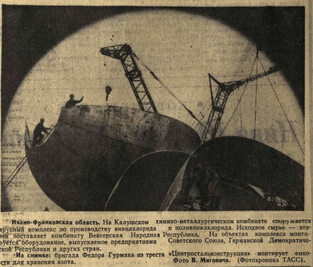
Ивано-Франковская область. На Калущком химико-металлургическом комбинате сооружается крупный комплекс по производству винилхлорида и поливинилхлорида. Исходное сырье — этилен — поставляет комбинату Венгерская Народная Республика. На объектах комплекса монтируется оборудование, выпускаемое предприятиями Советского Союза, Германской Демократической Республики и других стран.
