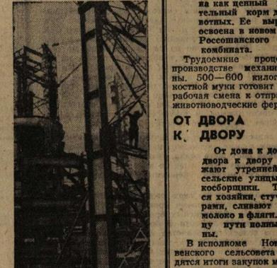
Монтаж металлоконструкций на строительстве домовой печи № 4 объемом 3200 кубометров на Карагадинском металлургическом комбинате в Казахстане. Фото Ю. Кудява. (АПН).
