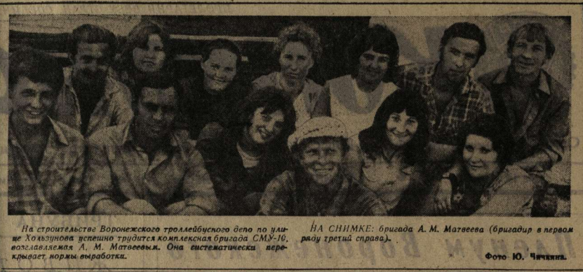
На строительстве Воронежского троллейбусного депо по улице Хомяковской работают бригады бригады СММ-16, возглавляемая А. М. Матвеева. Она систематически проверяет нормы выработки.
