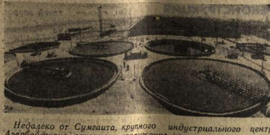
Недалеко от Симазита, крупного индустриального центра Азербайджана, закончено сооружение новых очистных установок. Протяженность всего комплекса сооружений здесь достигла 182 тысяч квадратных метров воды в сутки. НА СНИМКЕ: комплекс очистных сооружений, сооруженный на Каспийском побережье. Он занимает площадь почти 40 гектаров.
