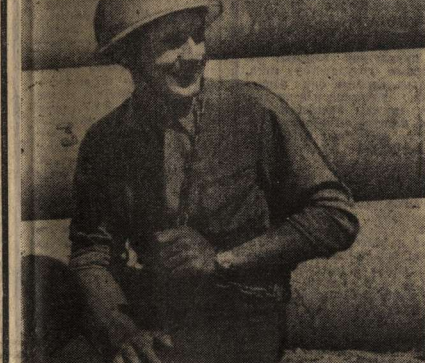
Иван Шишло — известный монтажник в Воронежском обкомстроительном комбинате. По итогам двух ударных недель он держит одно из первых мест в социалистическом соревновании. Здесь все работает под девизом — 25 ударных недель — XXV съезду партии. Качество строительства жилья во многом зависит от монтажников. Поэтому борьба за качественные показатели здесь всегда стоит на первом плане. Фото С. Евстратов.
