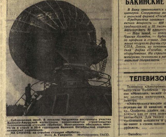
Хабаровский край. В поселке Чегдомине восточного участка Байкало-Амурской магистрали телевизионной станции «Орбита». Монтирование общенациональной трансляции. На снимке: на строение станции «Орбита». Фото А. Галушко. (Фотокорреспондент ТАСС).
