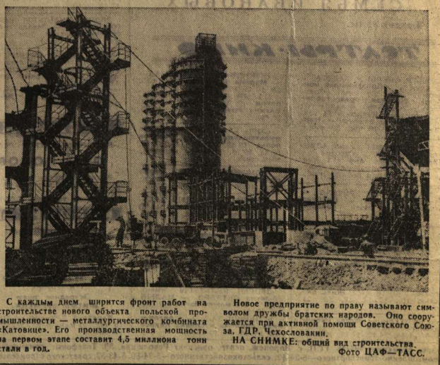
С каждым днем ширится фронт работ на строительстве нового объекта польской промышленности — металлургического комбината «Катовице». Его проектная мощность на первом этапе составит 4,5 миллиона тонн стали в год. Новое предприятие по праву называют символом дружбы братских народов. Оно сооружается при активной помощи Советского Союза. Г. П. Хельмгольц. НА СНИМКЕ: общий вид строительства. Фото ЦАФ — ТАСС.
