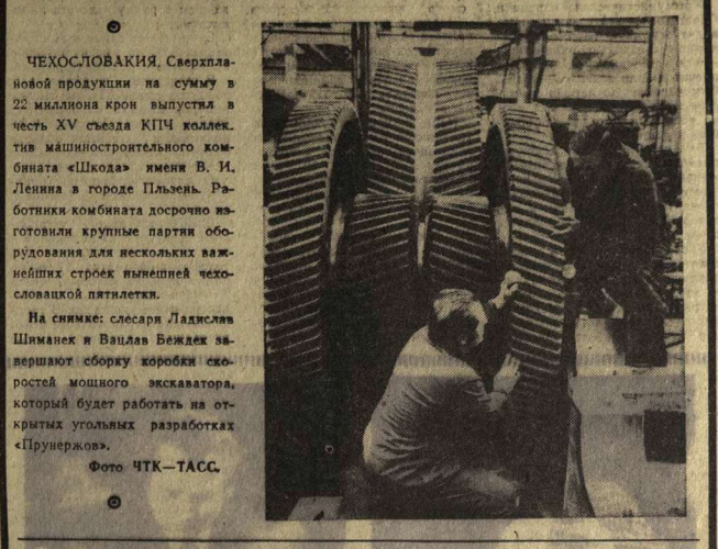
ЧЕХОСЛОВАКИЯ, Сверхплавной продукции на сумму в 22 миллиона крон вывезла в честь XV съезда КПЧ коллектив машиностроительного комбината «Шкода» имени В. И. Ленина в городе Пльзень. Работники комбината досрочно изготовили крупные партии оборудования для нескольких важнейших строек внешней чехословацкой пятилетки.
