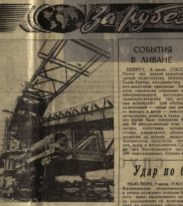
ПОЛЬША. В завершающую стадию вступает строительство металлургического комбината «Катовице», сооружаемого при техническом содействии Советского Союза. В четвертом квартале нынешнего года крупнейшее металлургическое предприятие республики даст первый металл.
