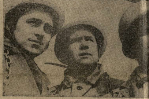
В бригаде монтажников СМУ-51 строительного треста № 2 под руководством Д. А. Акимова.
