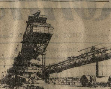
БЕЛГУЗОВСКИЙ топливно-энергетический комплекс — крупнейшая стройка пятилетия в народной Польше. Он будет введен в строй в 1980 году. Этот мощный экскаватор (на снимке) будет работать на открытой добыче бурого угля.
