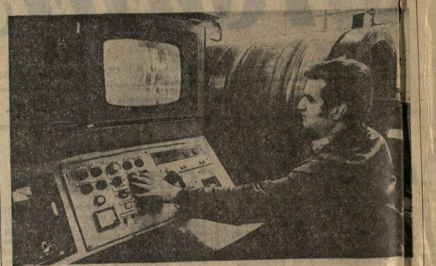
По законам сотрудничества Оборудование по заказу нефтяной промышленности ЦРП изготовляет завод химического оборудования в Восточном Маркс-Штаде (ГДР). На этом снимке Юрий Хман контролирует производственный процесс с помощью установки промышленного телевидения.
