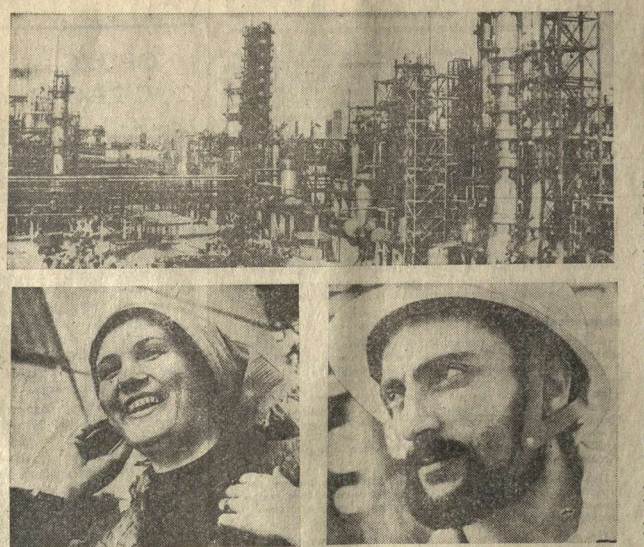
Широкая программа реконструкции осуществлена на заводе СК имени Кирова. На снимке: реконструированное производство синтетического каучука СКД. А вот активные участники промышленного строительства — командир передовой бригады бетонщиков СМУ-51 Татьяна Берченко и бригадир плотников СМУ-27 Владимир Оганян.
