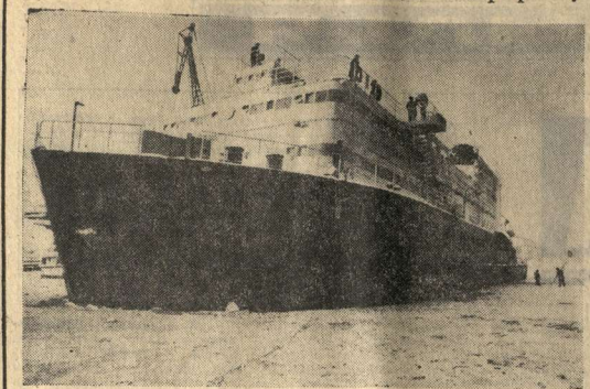
ТОМСКАЯ ОБЛАСТЬ. Начат монтаж главной энергетической установки плавучей электростанции «Северное сияние». Это первая в стране электростанция-букан, которая оснащена мощными турбинами на природном газе.
