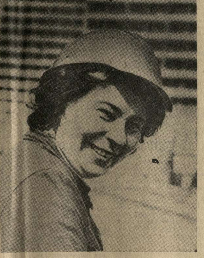
Успешно трудится на строящемся мосту комсомольско-молодежная бригада штукатуров коммунистического треста в Воронежском домостроительном комбинате, возглавляемая Ниной Федоровной Кондусовой. И это во многом объясняется умелым и квалифицированным руководством бригады. Свои знания и опыт, любовь к профессии, добросовестное отношение к порученному делу она настойчиво прививает своим подчиненным.
