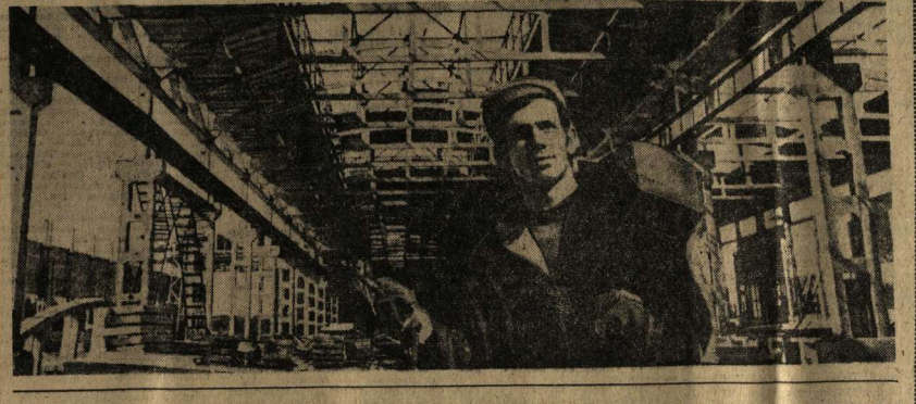
НА СНИМКЕ: строительство нового литейного цеха на Воронежском заводе горно-обогатительного оборудования...
