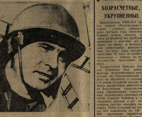
Четверть века трудится в первом Воронежском специализированном строительно-монтажном управлении треста «Югостальконструкция» Александр Николаевич Мешков. Это время он стал настоящим мастером монтажного дела...
