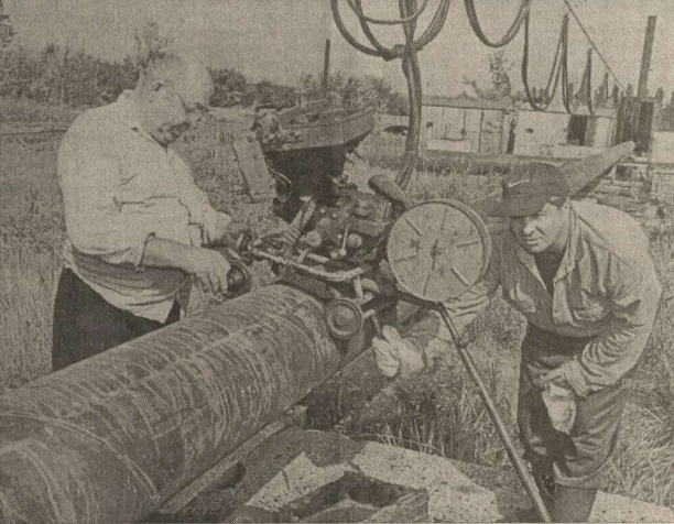
Этот снимок был сделан более месяца назад на трубостроительной базе «Воронежтрубопроводострой» под Воронежем. Электросварщик Владимир Бурчаков (слева) и шифровальщик Владимир Евтухов готовят последние метры для газопровода до Анны. Накануне 45-летия начала газификации Воронежской области все 82-километровая ветка, проходящая по Новоусманскому, Панинскому и Аннинскому районам, сдадена в эксплуатацию. Дмитрий ДЕНИСЕНКО. Фото Олега ПОЛЕХИНА.
