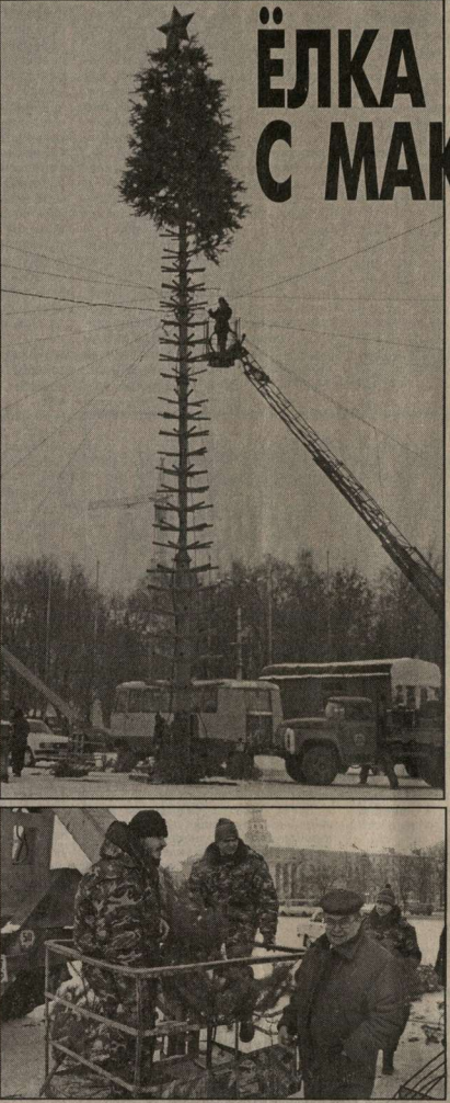
Сергей КРОЙЧИК. На снимках: монтаж главного городского ёлки ведется под руководством А.Гайдукова. Фото Олега ПОЛЕХИНА.
