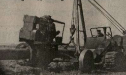
1986 год. Строительство первой нитки газопровода Ставрополь-Москва.
