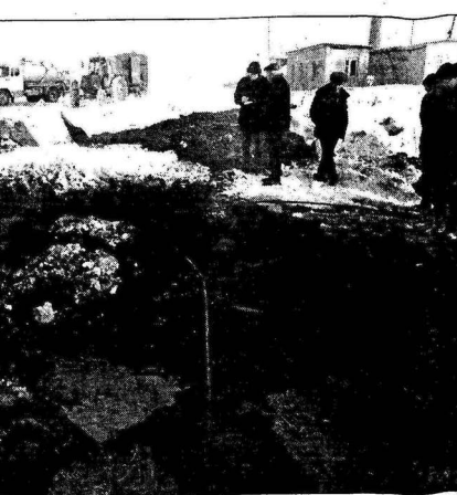
Ликвидация аварии в Северном микрорайоне.
