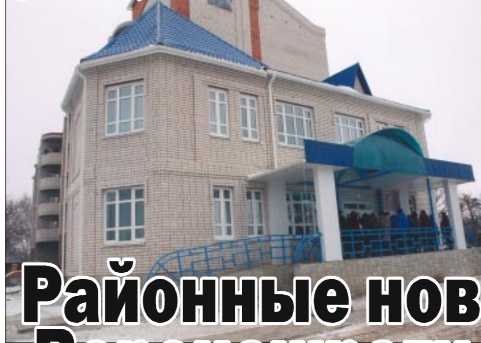
Здание абонентской службы в Россоши.
