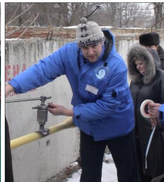
Врезка в действующий газопровод с помощью изобретения калачеевских газовиков.
