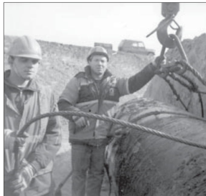
Демонтаж трубы ведут дорожники Андрей Томинов и Вадим Погорелов.
