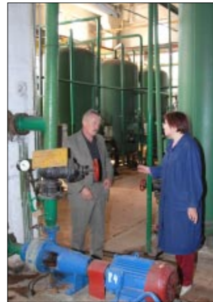
Есть и другая проблема, связанная с отоплением, когда в одном и том же доме и даже подъезде батареи греют по-разному.
