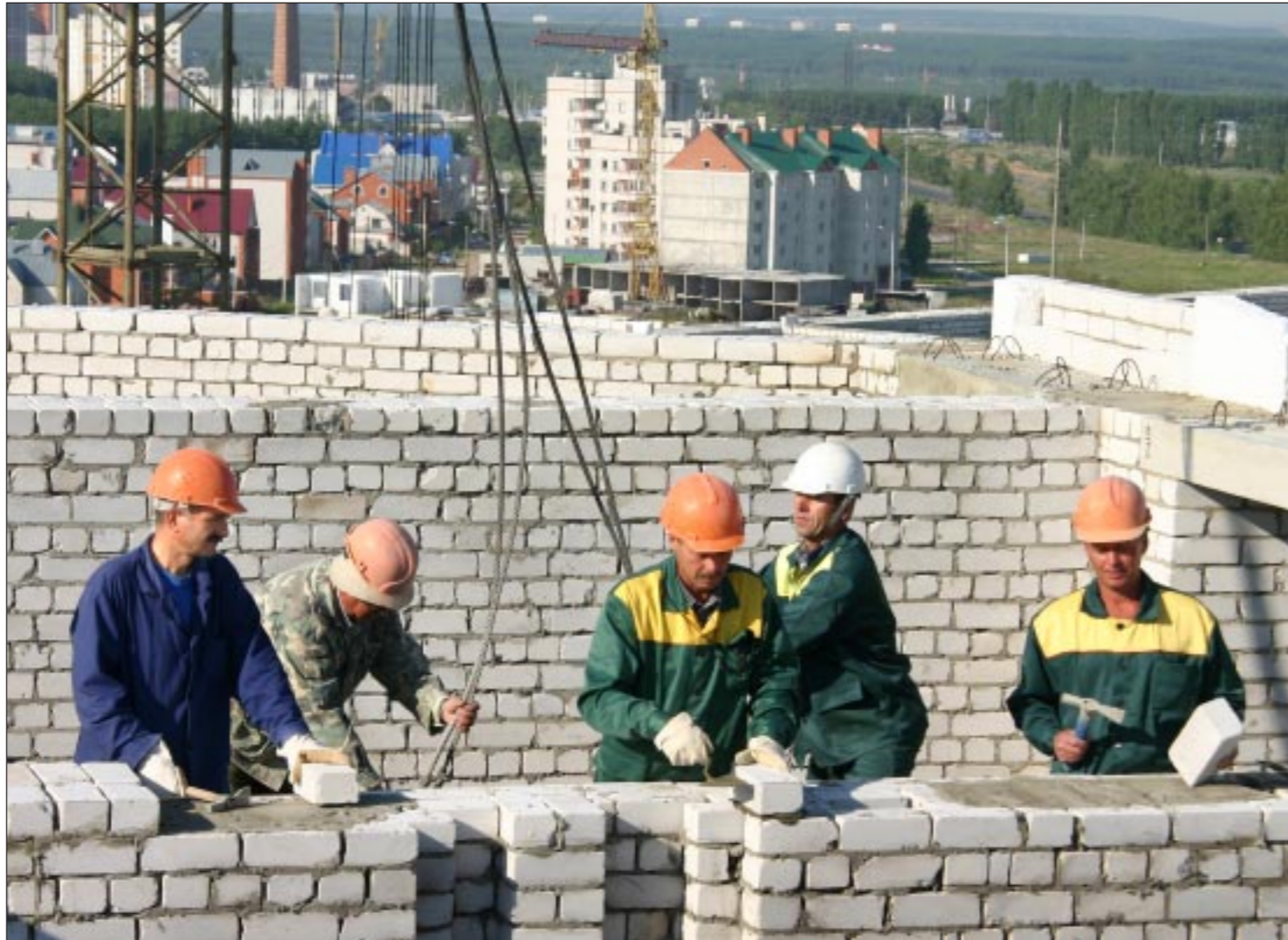
Этот снимок сделан вчера нашим фотокорреспондентом на 10-м этаже новостройки, которая растет на улице Антонова-Овсеенко в Северном микрорайоне Воронежа. Ведет строительство ЗАО «ВМУ-2». Прежде эта организация специализировалась на монтаже систем водоснабжения, отопления и канализации, но с середины 90-х годов достаточно внушительно и зримо заявила о себе на рынке жилья. Его возведено уже более 100 тысяч квадратных метров. НА СНИМКЕ: одна из лучших бригад каменщиков ВМУ-2, возглавляет которую Алексей Мезенцев.
