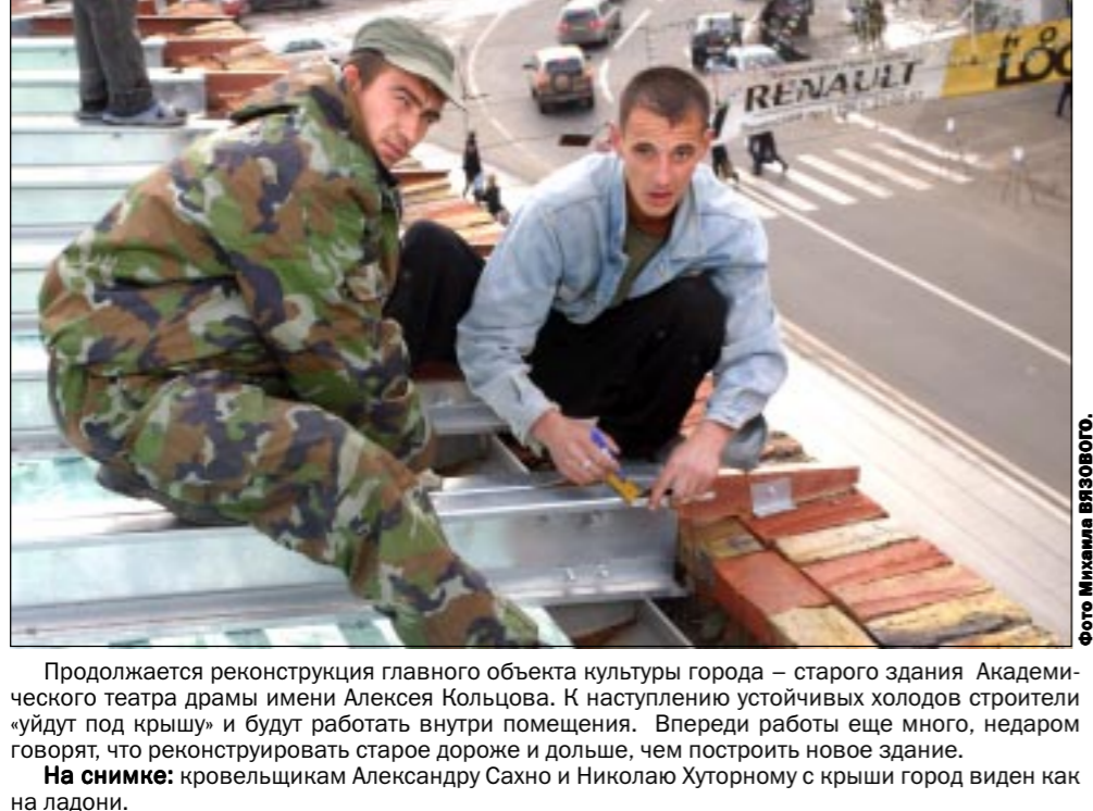
Продолжается реконструкция главного объекта культуры города — старого здания Академического театра имени Алексея Кольцова. К наступлению устойчивых холодов строители «уйдут под крышу» и будут работать внутри помещения. Впереди работы еще много, недаром говорят, что реконструировать старое дороже, чем построить новое здание.
