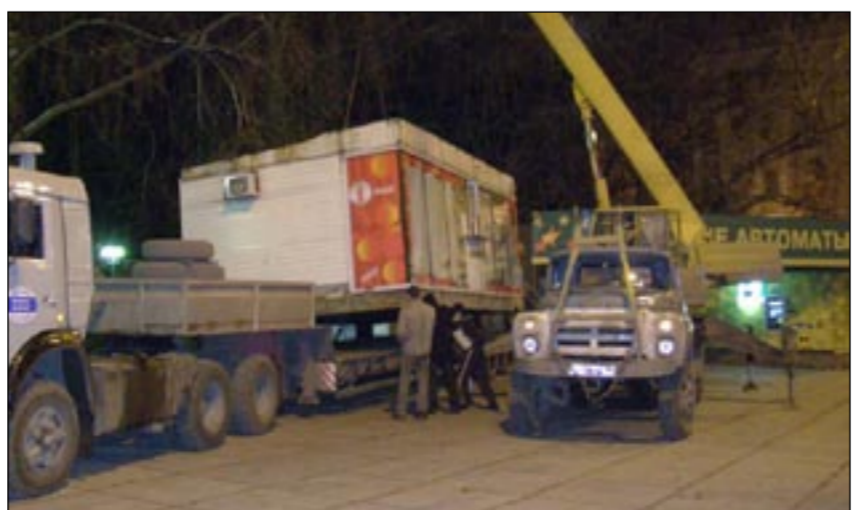
Идет демонтаж игорного павильона.
