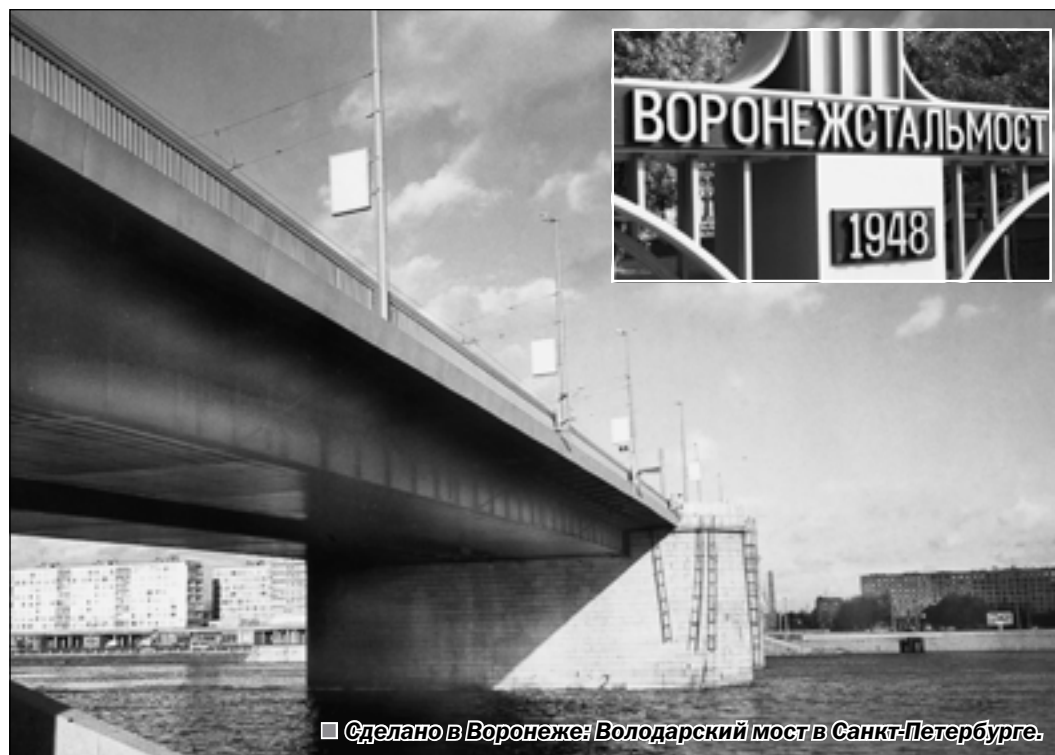
Сделано в Воронеже: Володарский мост в Санкт-Петербурге.
