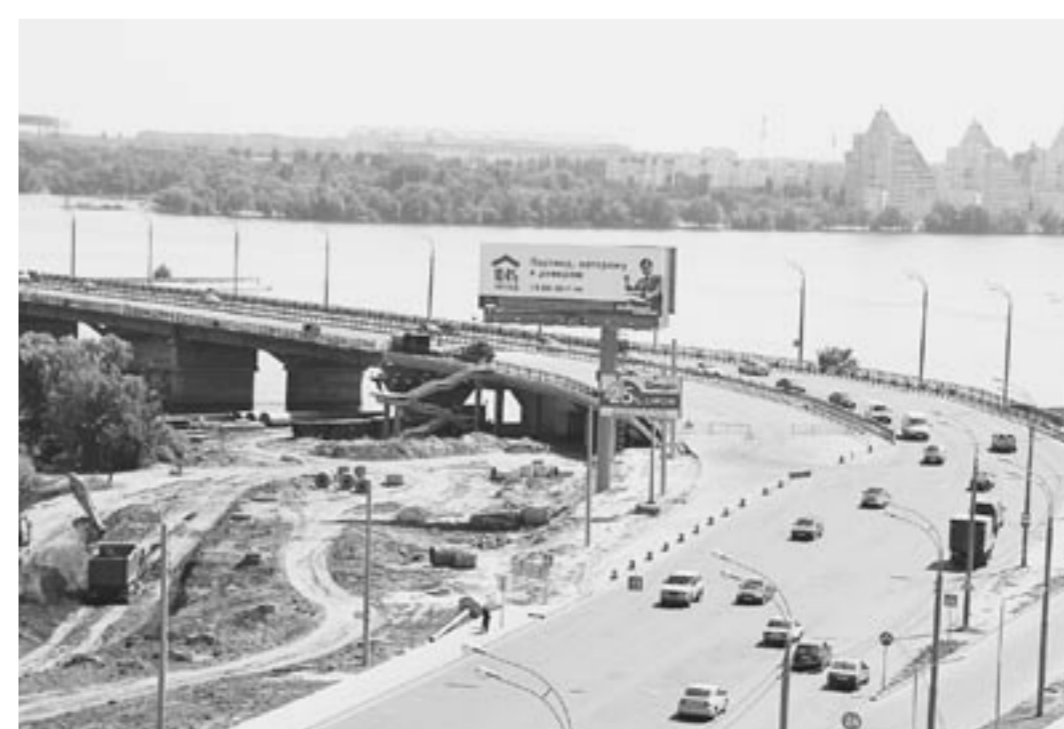
Строительство Чернавского моста.
