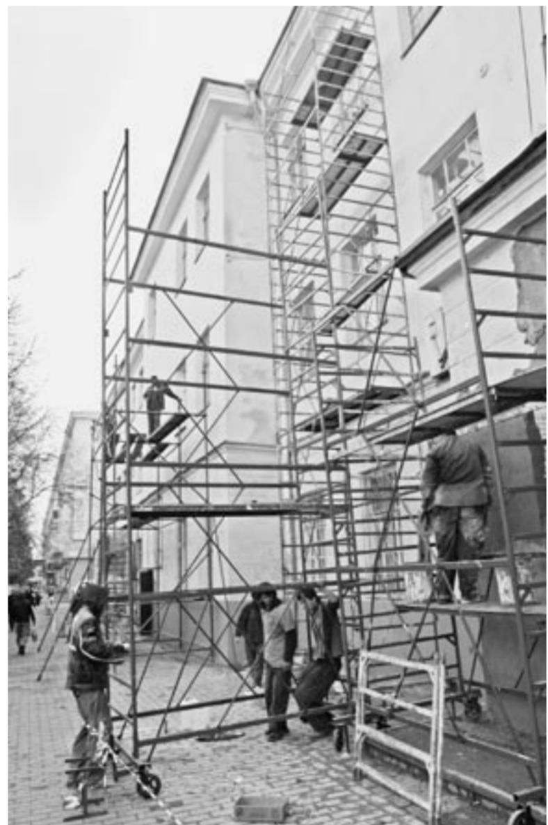
Воронежская школа № 35 все ещё в строительных лесах.
