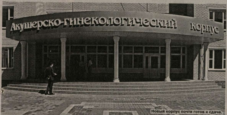
Новый корпус почти готов к сдаче.
