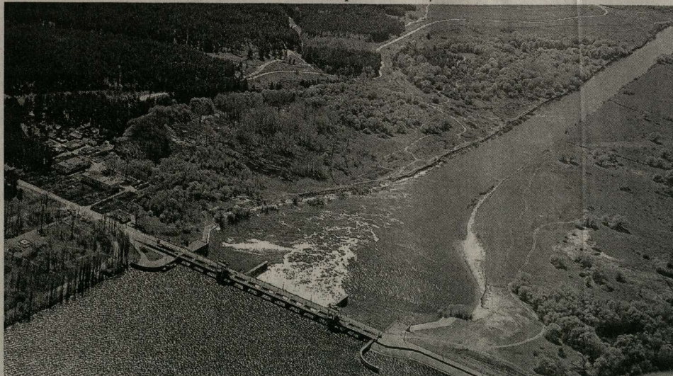
Плотина водохранилища. Снимок сделан с высоты, как в пейзаж мог внести свои коррективы пожар.
