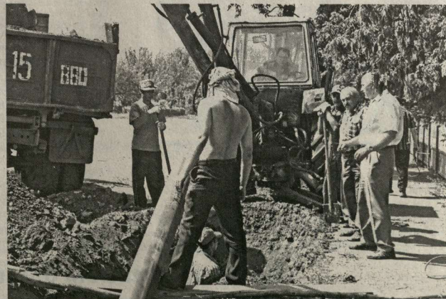
Идут работы по укладке трубопровода на одной из главных водопроводных артерий города.
