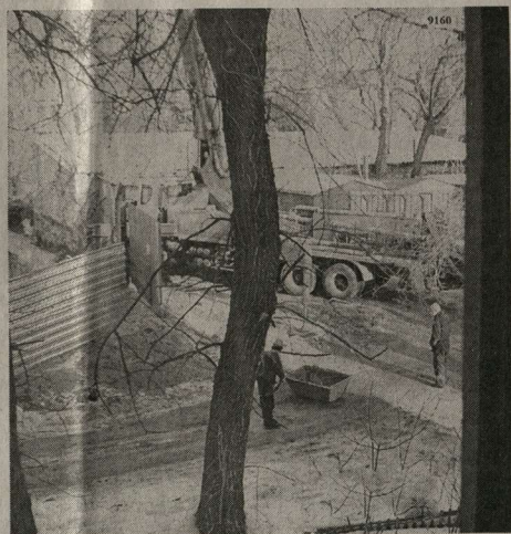
А из нашего окна стройка мощная видна...
