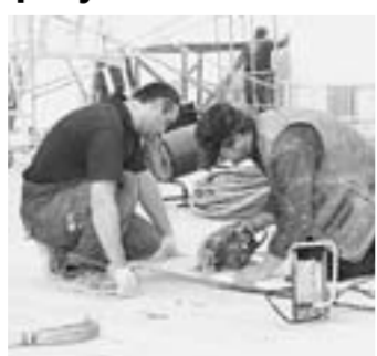
Идёт ремонт спортзала.
